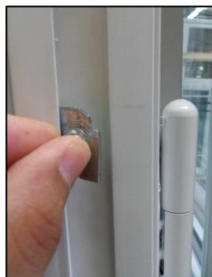
Pose du clameau dans la rainure
