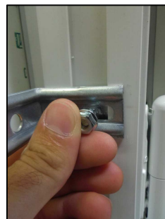
Pose de la patte et de l'écrou
