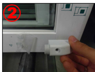
Placer la tige métallique de la butée dans le trou de 8mm.
